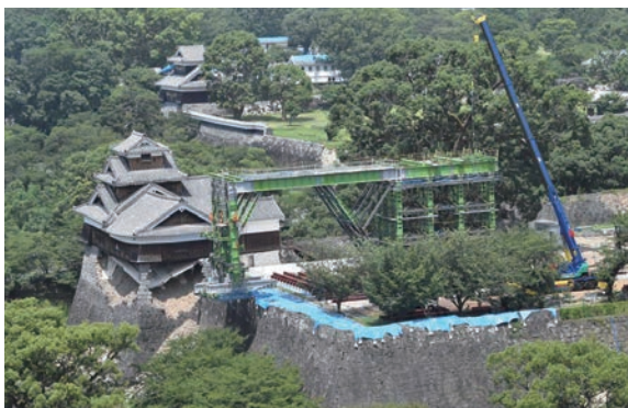
복구공사를 시작한 구마모토성의 이이다마루 고카이야구라(飯田丸五階櫓)
